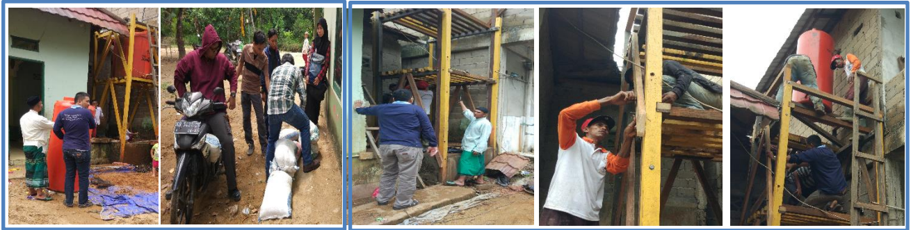
(a) (b) Gambar 4. (a). Pengangkutan Alat dan Bahan; (b) Pembuatan Dudukan Instalasi Pengolahan Air Bersih
