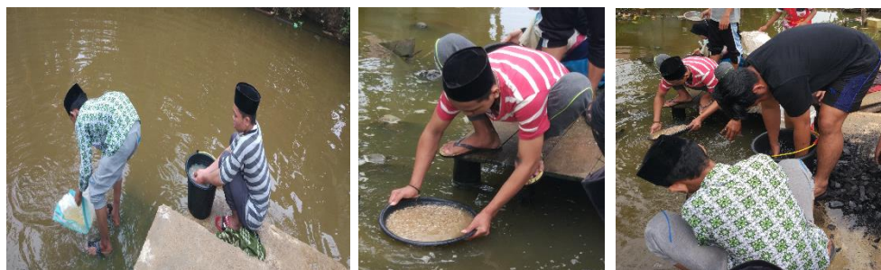
Gambar 6. Pembersihan Bahan Filter Pasir Kerang
