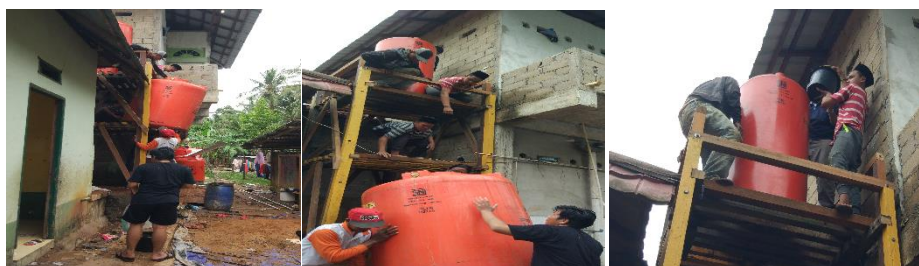
Gambar 7. Perakitan Instalasi Pengolahan Air Bersih
