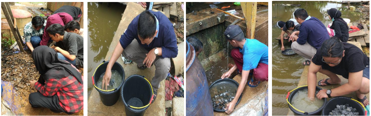
Gambar 5. Pembersihan Bahan Filter Kerikil
